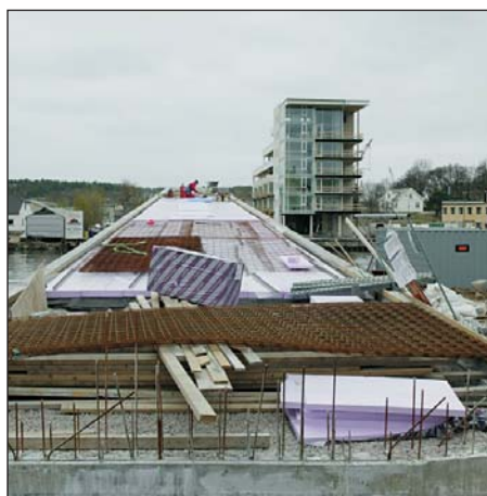
Ny gangbro, Fredrikstad.
