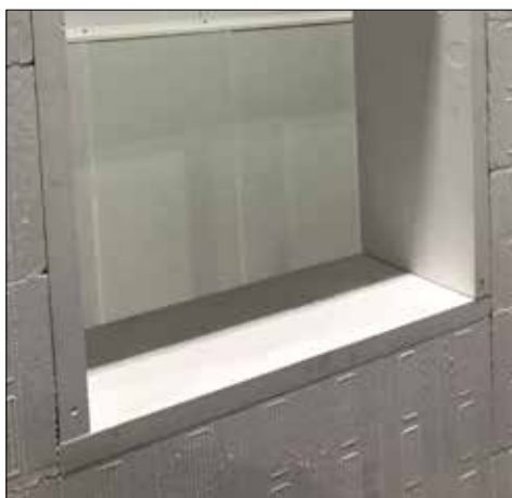
Jackopor Plank 350mm Montert som smyglist i Thermomur 350
