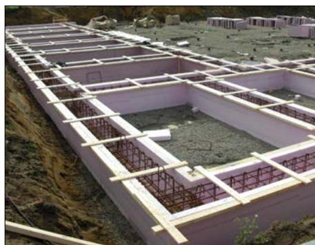
Jackofoam® Fundamentkasser Spesial Produseres i ønsket mål og trykkfasthet med freste spor for sidevangene.
