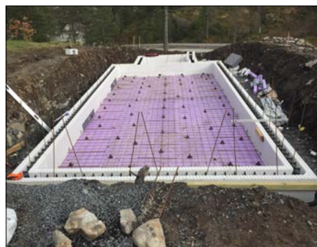
Jackon Thermomur® 250x Basseng med tilbakefylling
